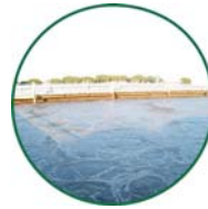
PLANTAS DE TRATAMIENTO DE AGUAS
