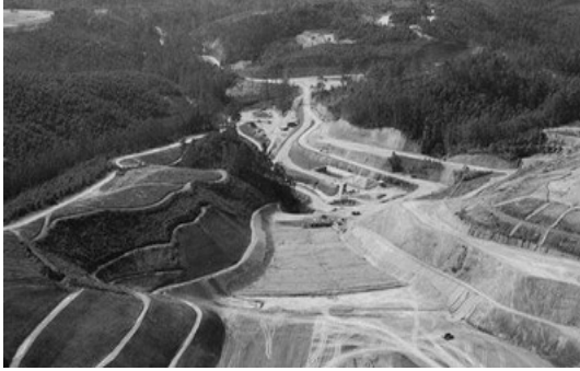
e. Relleno Sanitario Essencis
