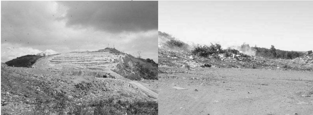
a. Vertedero Volta Redonda - inadecuado
