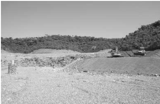
i. Relleno Sanitario CTR Nova Iguaçu
