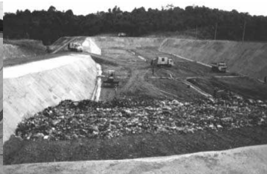
h. Relleno Sanitario de Salvador
