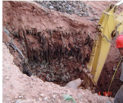
Excavación de 5 a 7 metros de profundidad
