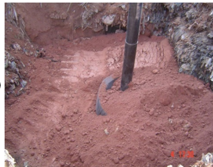
Relleno con suelo compactado - sellado
