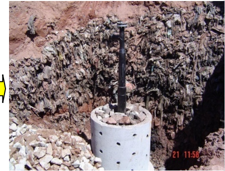
Instalación de nueva tubería de concreto y la cabeza
