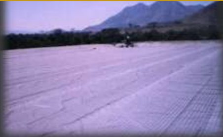
Colocación de Geomembrana
