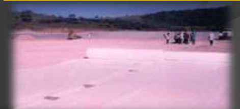
Colocación de geotextil
