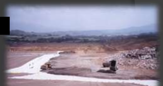
Colocación de geotextil
