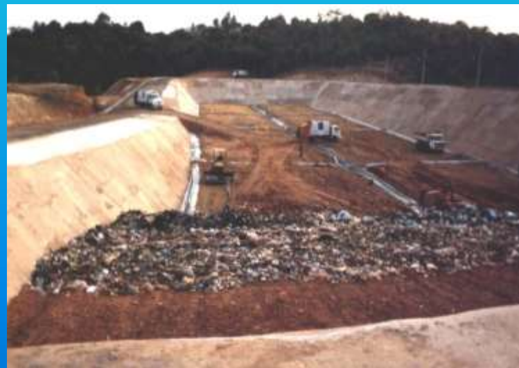
Aterro Sanitário de Salvador
