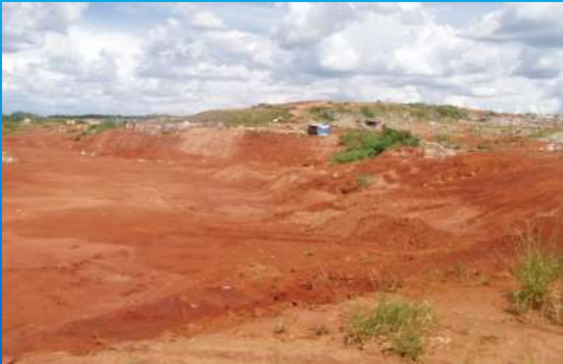
Aterro Controlado de Anápolis
