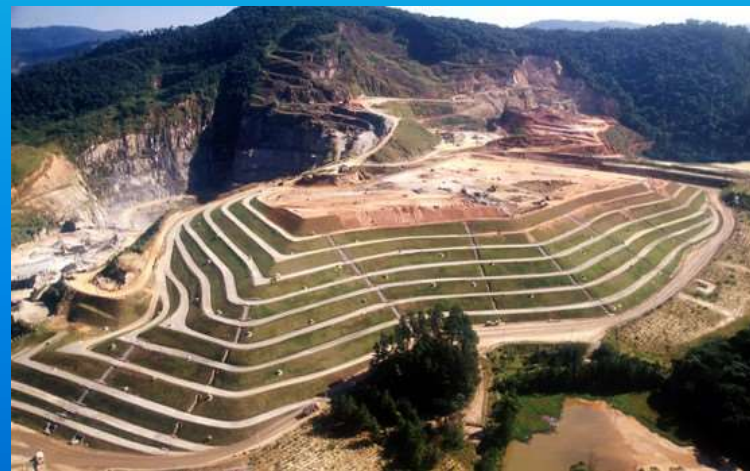
Aterro Sanitário Estre – CDR Pedreira
