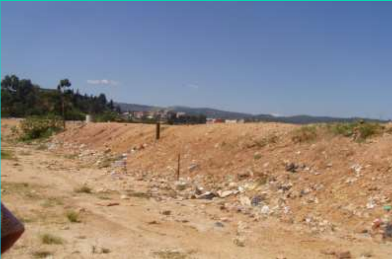
Aterro Controlado Santana do Parnaíba
