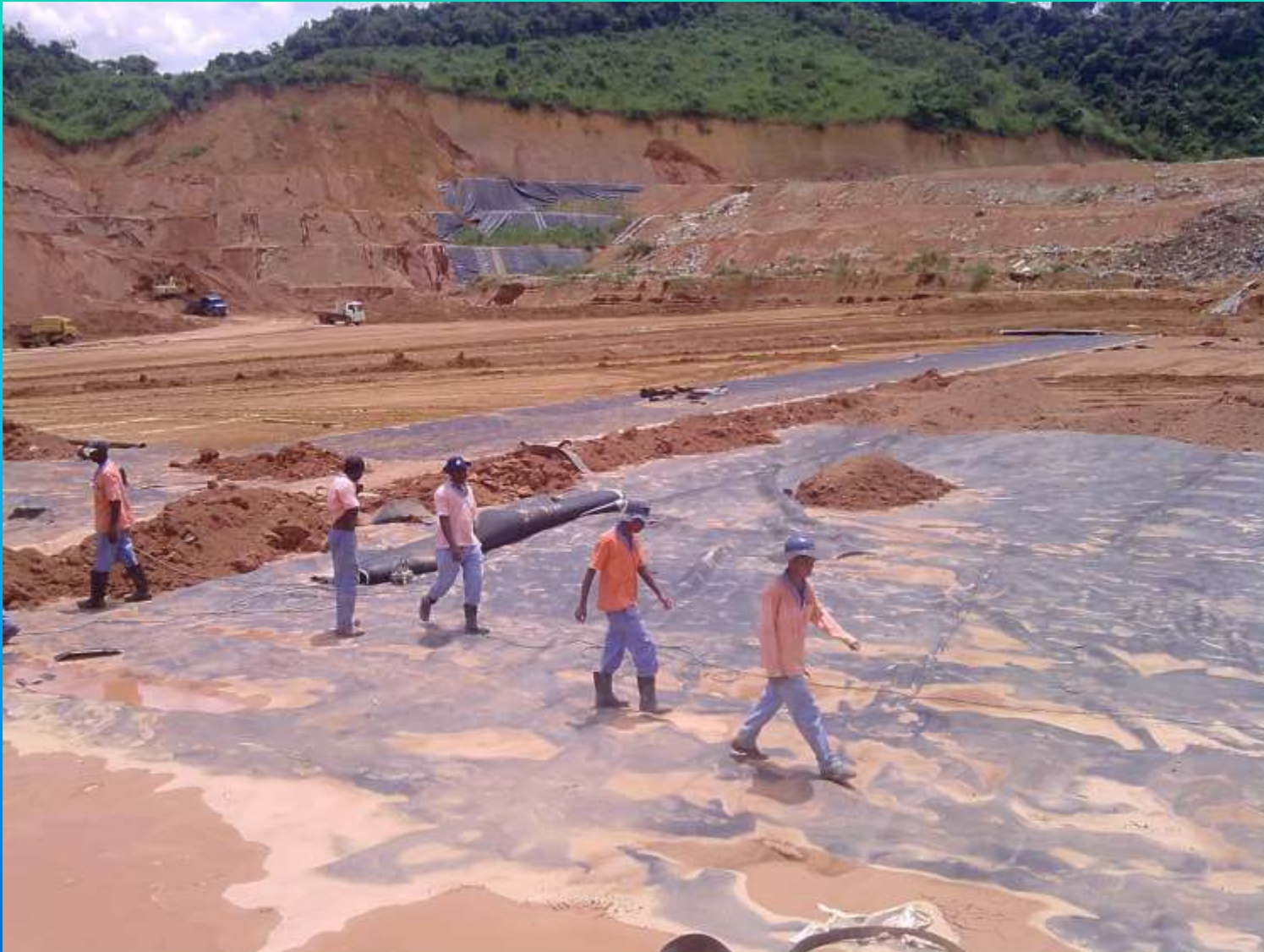
Impermeabilização de base
