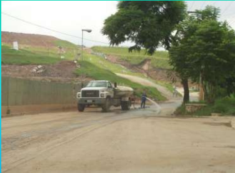
Aterro Sanitário de Santo André
