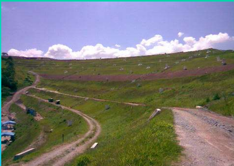
Aterro Sanitário de Santo André
