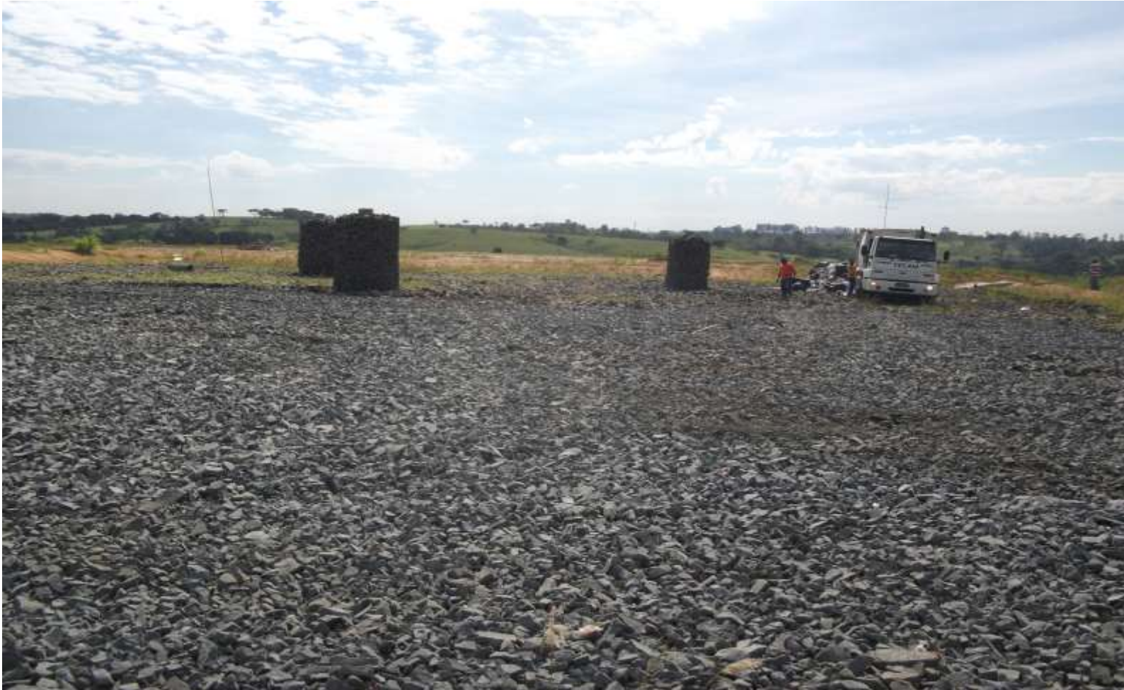
Figura 6: Dreno vertical de Gás.
