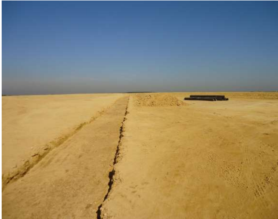
Figura 4: Canaleta de Drenagem do lixiviado.
