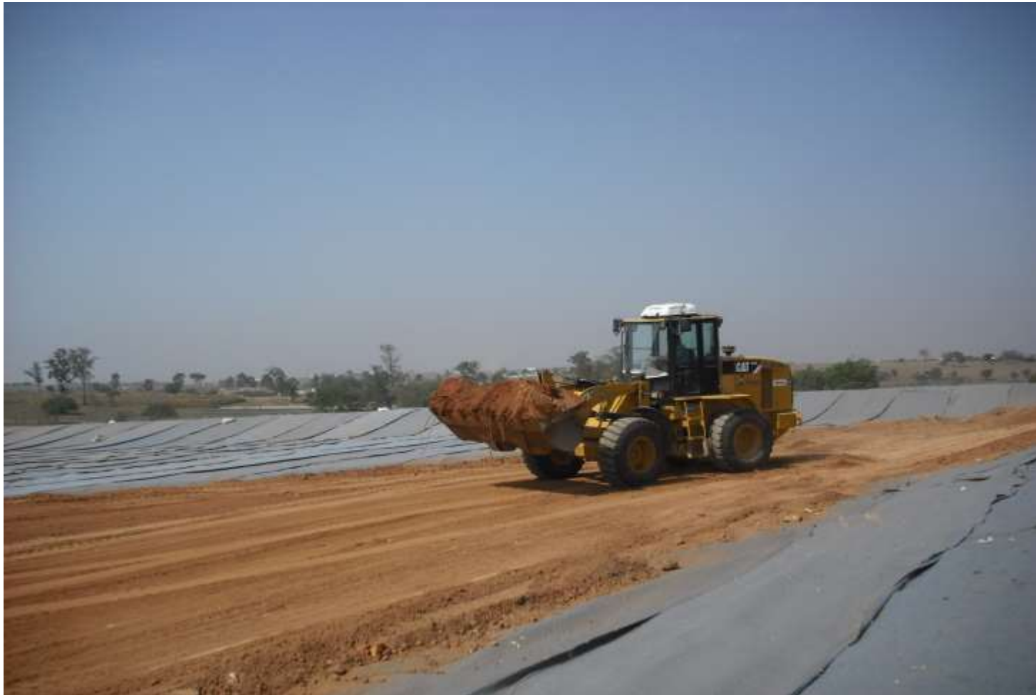
Figura 3: Camada de solo para proteção da geomembrana não tecida.
