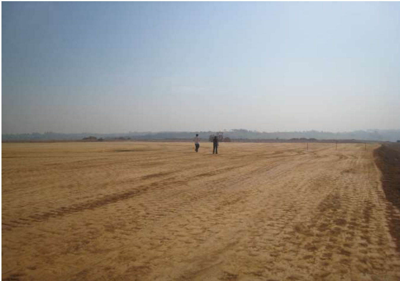
Figura 1: Compactação do solo da base da célula.
