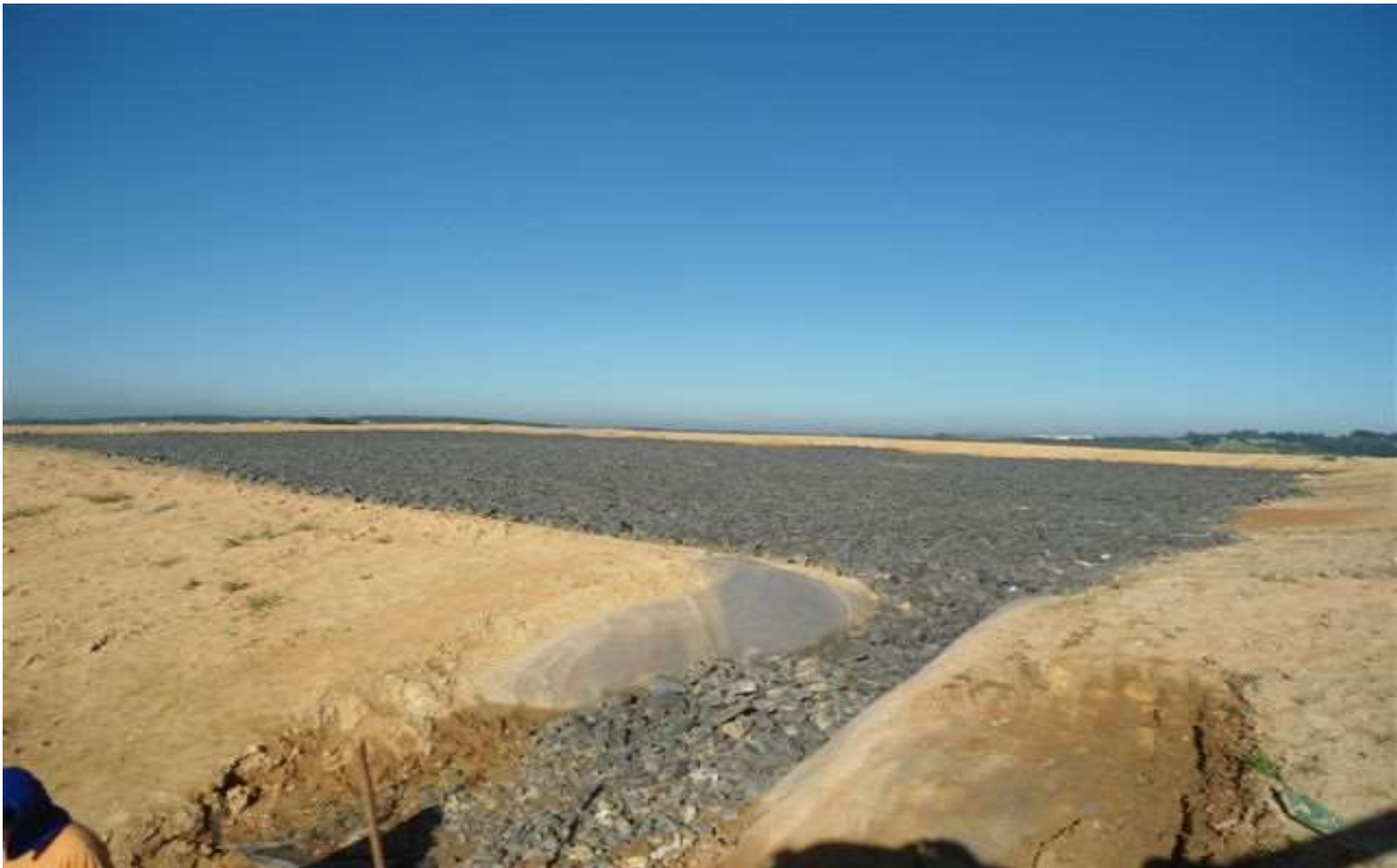
Figura 5: Sistema drenante.
