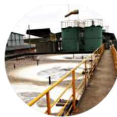
Tratamento de Efluentes
