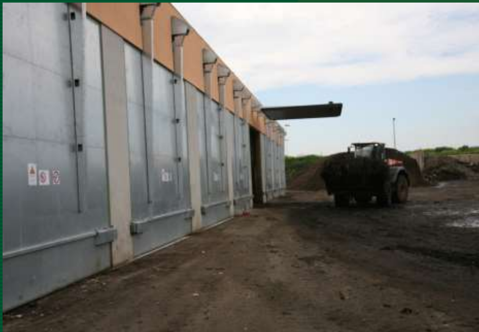
Digestor tipo Tunel
