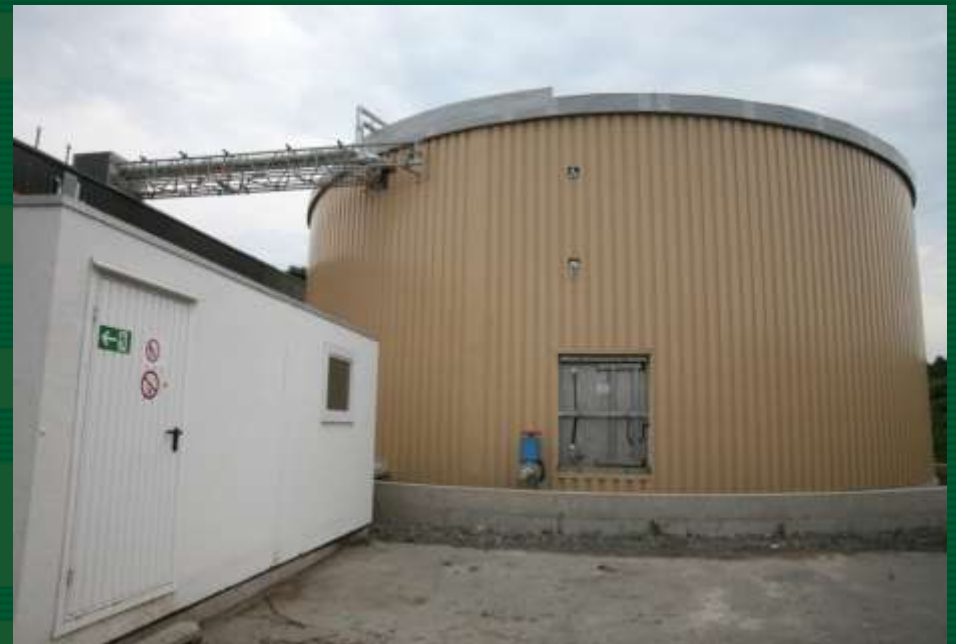
Tanque para almacenar liquido de recirculación
